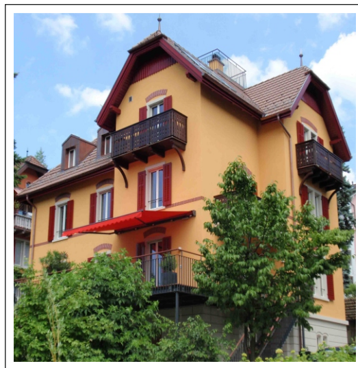
nach der Renovation
