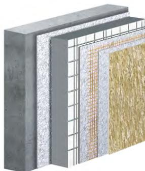
Die Systeme **K5 EPS grau**, **K5 PUR**, **K5 PIR** et **K6** können durch das verstärkte Mittelschicht-Putzsystem durOeco in ihrer Resistenz und Mineralität aufgewertet werden.
