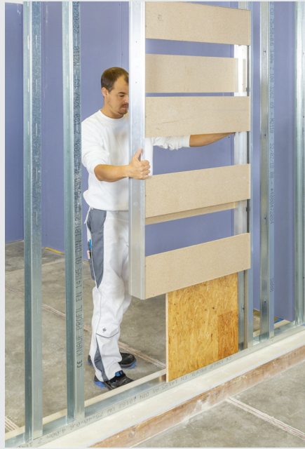
Grundrahmen einsetzen
