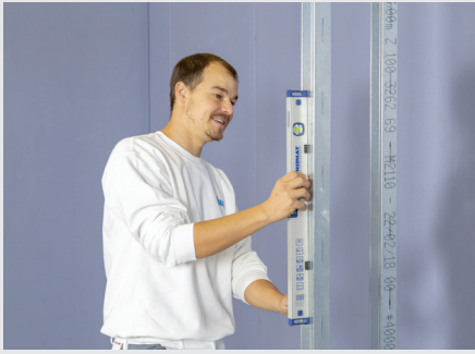
Anschlagprofil ausrichten und vercrimpen
