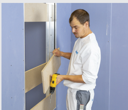
Transportsicherungen entfernen
