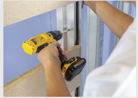
Grundrahmen verschrauben
