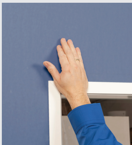
Abdeckrahmen einsetzen
