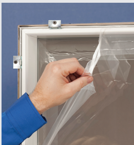
Schutzfolie entfernen
